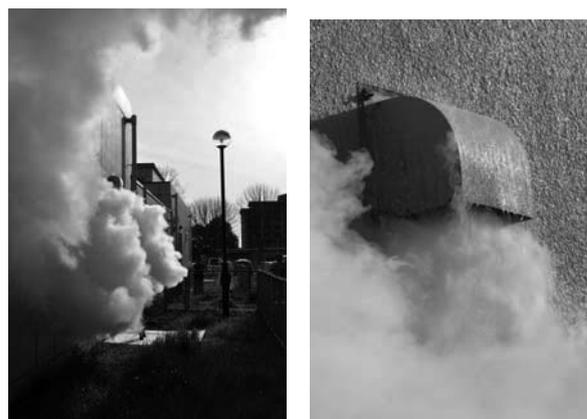
(a)クエンチ直後の放出口 (b)放出口カバーの空気の液化
